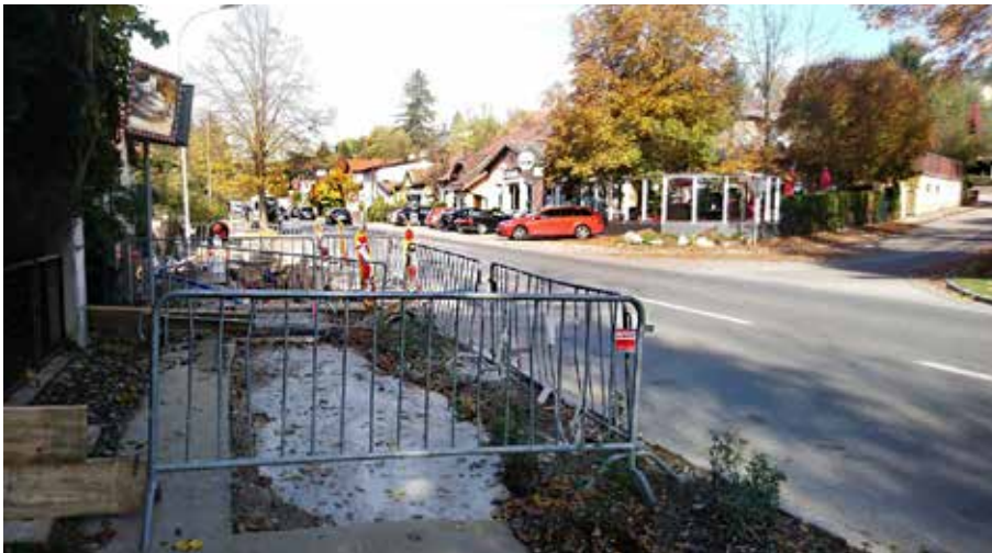
An dieser Baustelle führt kein Weg vorbei - außer als Autofahrer_in.
